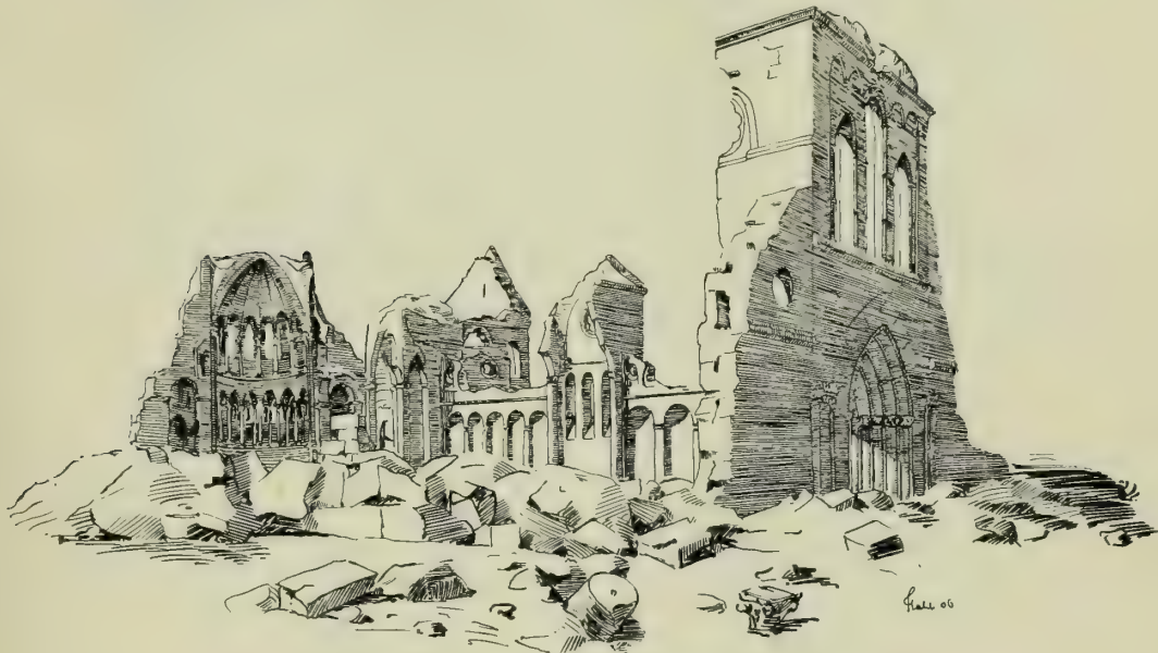
Fig. 31. Heisterbach. Die Klosterkirche während des Abbruchs.
